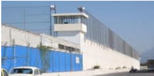
3.1.4 Instalaciones del CERESO Tehuacán. Fuente archivos CERESO
